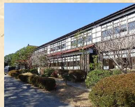
耐震診断・改修設計 木造大規模校舎 (萩市 明倫学舎)
