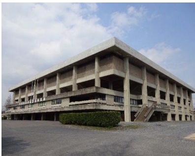
RC 造（屋根 S 造）体育館
