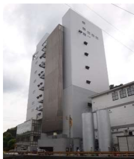
S 造高層ビル
