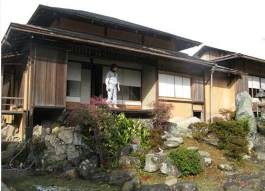
彦根城の敷地内にある「地震の間」の木造建築。大小多数の岩で地盤が補強されている ＝滋賀県彦根市
