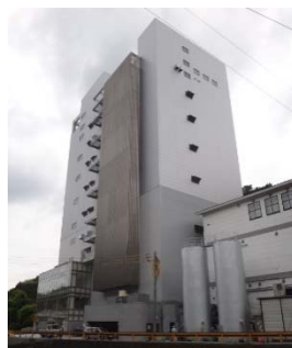
S 造高層ビル
